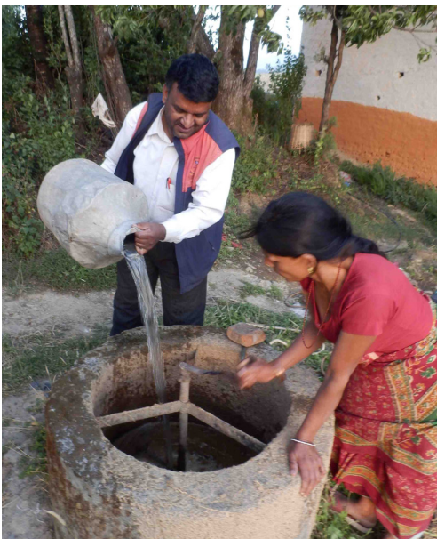
Befüllen einer Biogasanlage.
